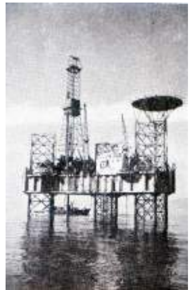
1960年代に海底油田開発で活躍した移動式海洋掘削装置「白竜号」
